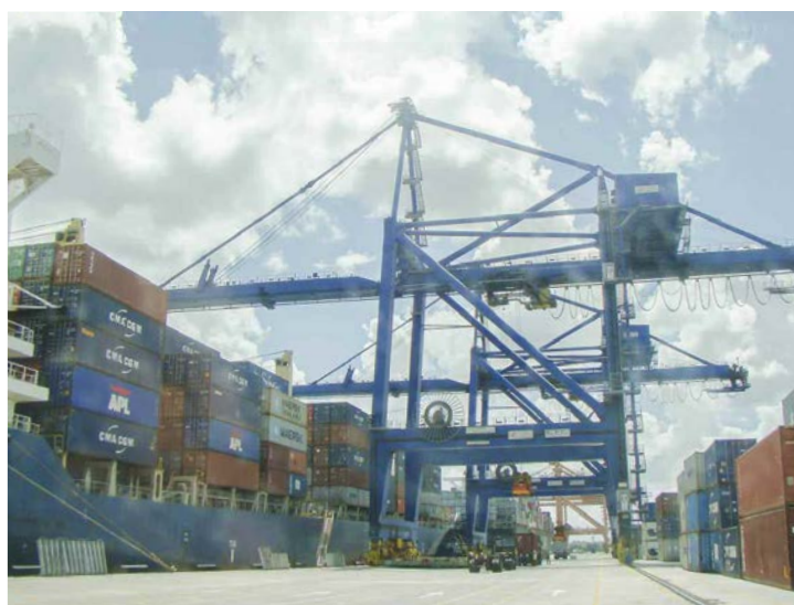
Vues partielles du quai et du Mauritius Container Terminal
